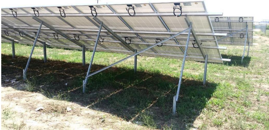
Slika 8. Izgled noseće konstrukcije
