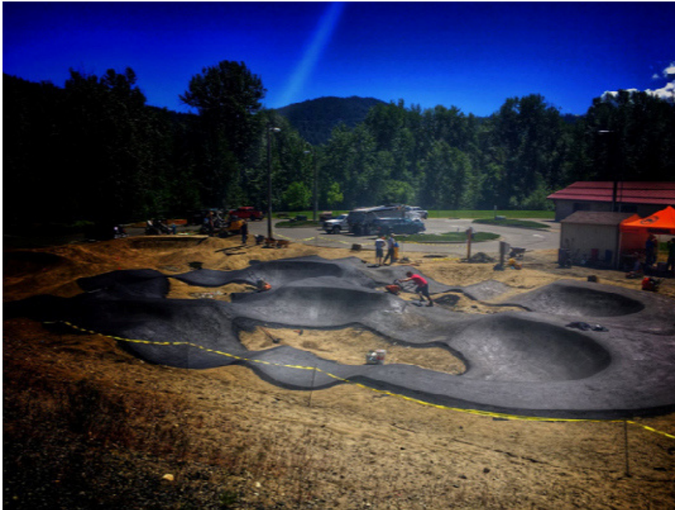
Slika: prikaz ugradnja asfalta na poligonu
