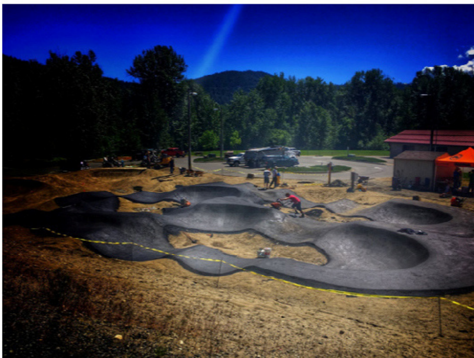
Slika: prikaz ugradnja asfalta na poligonu
